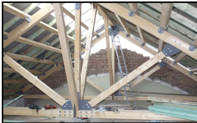
A katolikus templom új tetőácsolata, 2012. szeptember.
